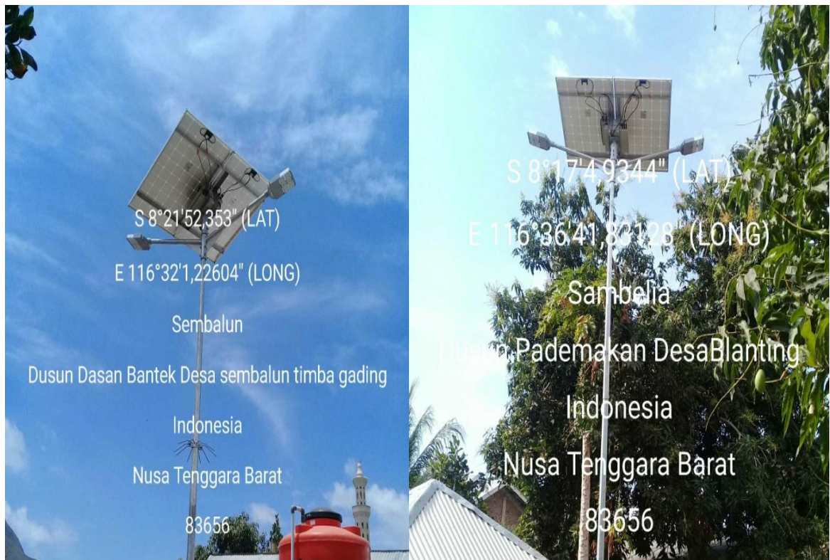
Gambar 5.3. Pemasangan PJU-TS di Kabupaten Lombok Timur
